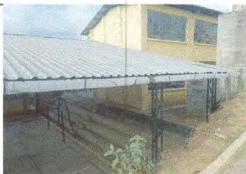
Foto 4: Sustitución de canal + bajadas de agua pluvial en cancha polideportiva
