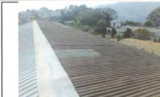
Foto1: Sustitución de lámina acanalada a lámina troquelada cal 26 del edificio escolar
