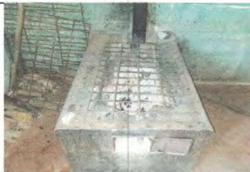
Foto 2: Sustrucción de plancha de metal de 3 hornillas
