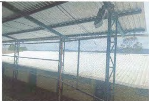
Foto1: Sustrucción de lamparas tipo LED tipo reflector 300w dl luxlite
