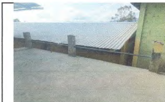
Foto 5: Mejoramiento de baranda perimetral en patio de la escuela primaria
