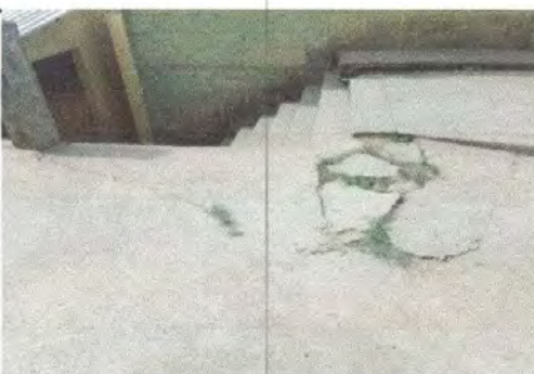
Foto 6: Reparación de planchas de concreto de patio (t=0.075)
